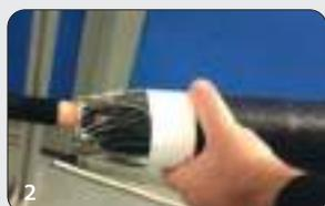
2 Posizionato al centro della connessione e fatto collassare sul cavo rimuovendo il supporto interno.
